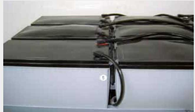
Verschlossene Bleibatterien gem. DIN EN 60896-2 mit Hitzeschäden
